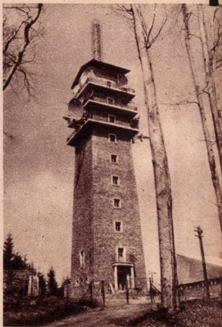
A kékestetői toronyépület, erkélyein a parabola-antennákkal. Az épület mögött van felállítva a helyi adó antennatornya, ennek sugárzó része emelkedik az épület teteje fölé
